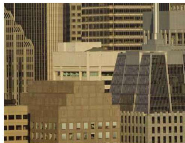
Автоматика зданий (ОВК)
